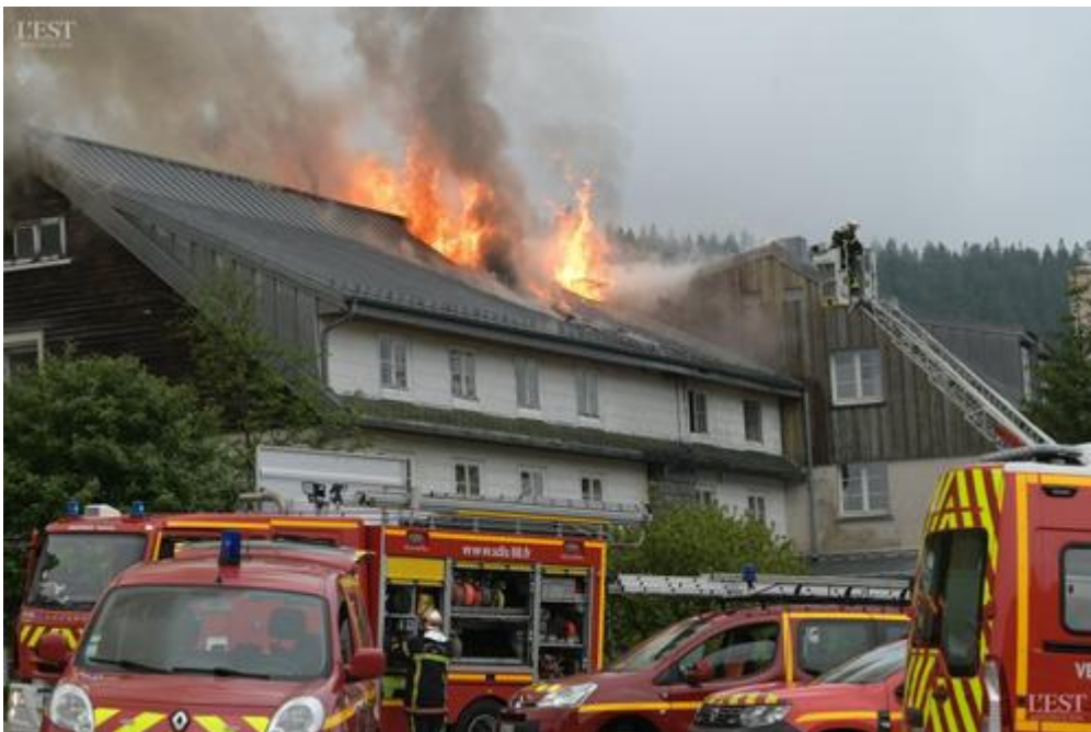
Le 2 juillet 2021, un incendie ravage l'hôtel du Rouge Gazon. Photo VM /Jerome HUMBRECHT
